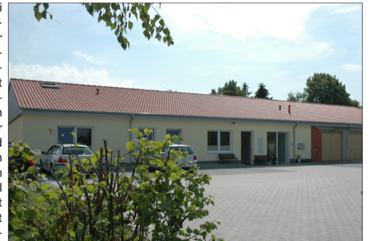
Das neue Ärztehaus in der Dr.-August-Müller-Straße 2. Rechts nebenan soll demnächst noch eine Apotheke eröffnet werden.
