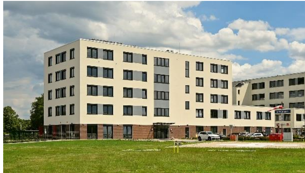
2. Bauabschnitt Gesundheitszentrum „Haus für Gesundheit“ in 31535 Neustadt am Rübenberge
